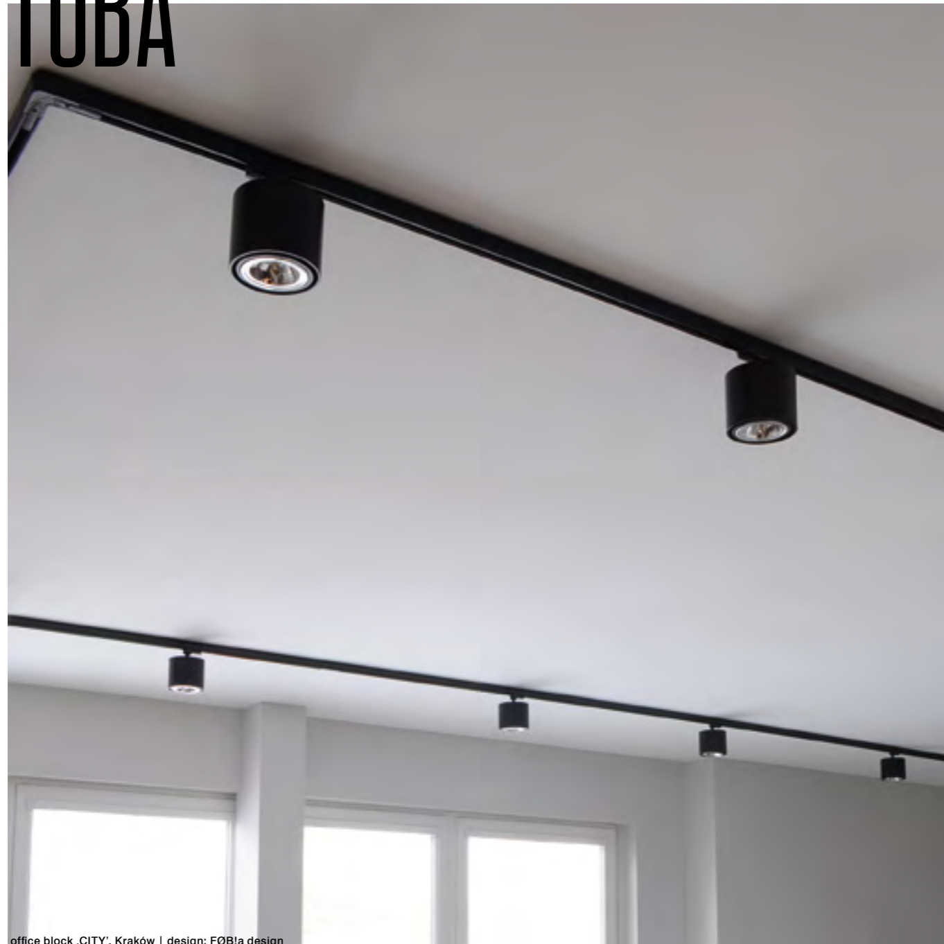
office block „CITY”, Kraków | design: FØB!a design
